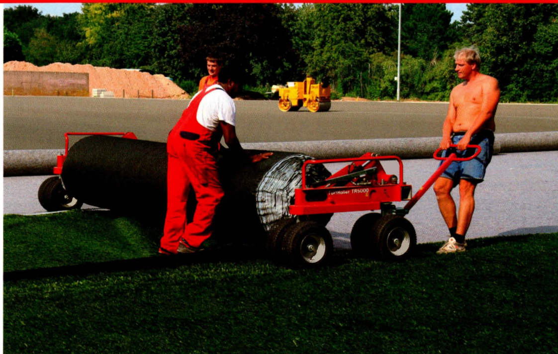
Nach modernstem Stand der Technik wurde der größere der beiden Tennenplätze im Stadion in einen Kunstrasenplatz umgewandelt. Hier werden die Kunstrasen-Bahnen auf dem vorbereiteten Untergrund verlegt.
